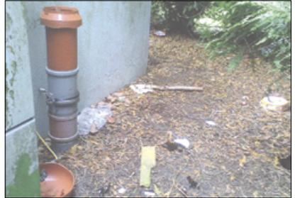
**Müll und abgerissener Deckel am Entlüftungsschacht des Hauptpumpwerks Klüden behindern den reibungslosen Betrieb der Anlage.**
