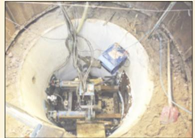
Mit einem der schwierigsten Verlegeverfahren wurde der Mischwasserkanal von einer Seite der Bahnlinie Haldensleben-Magdeburg auf die andere gebohrt: Dabei war vor allem permanente Techniküberwachung nötig.
