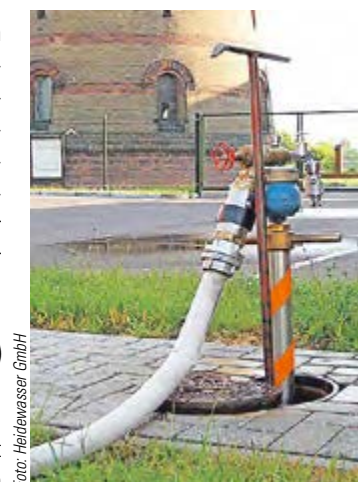
Heidewasser-Standrohr mit verbautem Systemtrenner.
